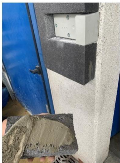
7. DOPO IL TAGLIO, INCOLLAGGIO COPERTURA SATFFA
