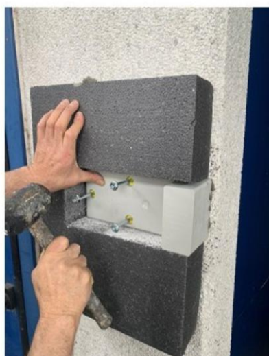
5. ALLOGGIAMENTO SATFFA E INSERIMENTO TASSELLI
