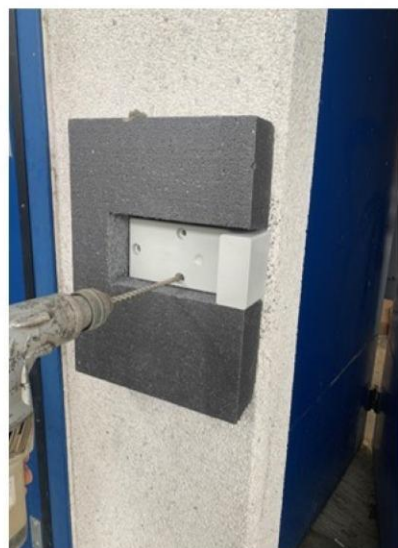
3. FORATURA DEL MURO
